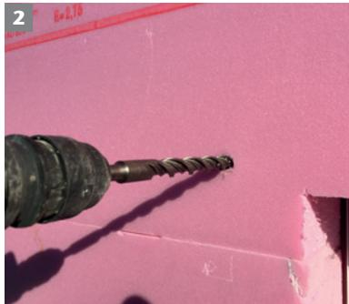
2 Sofern Bohrschablone nicht zur Hand, Lichtschacht mit eingelegtem Rost an die Wand halten und die zwei oberen Befestigungspunkte anzeichnen. Um in der Höhenposition flexibel zu bleiben, können die beiden oberen Befestigungspunkte auch innerhalb des Langlochs etwas tiefer gesetzt werden. Nun die Löcher mit einem 16 mm Bohrer bohren.
