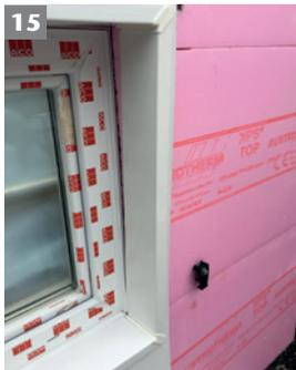
15 Dämmungsanschlussprofil gemäß Montageanleitung zusammenbauen. Rahmendichtung entfernen. Dämmungsanschlussprofil durch Rückwand schieben und in Rahmennut einstecken.
