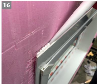
16 Dichtstoff oberseitig hinter die Rückwand eintragen. Rückwand gemäß Markierungen ausrichten und andrücken. Lichtschacht anschrauben. Rückwandposition nochmals prüfen. Ggf. korrigieren.
