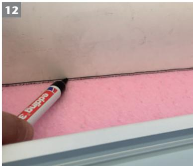
12 Fensterausschnitt von innen markieren. Hierzu an vorhandener Dämmung orientieren. Bitte Außenabmessung des Dämmungsanschlussprofils berücksichtigen. Ggf. Dämmung nachschneiden.
