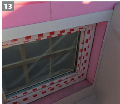
13 Rückwand entnehmen. Fensterausschnitt mittels Stichsäge ausschneiden. Schutzfolie entfernen. Rückwand wieder einschieben und ausrichten.
