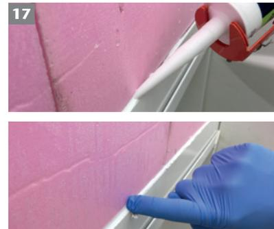
17 Dichtstoff nochmals im Übergang von Rückwand zu Dämmung oder Wand auftragen. Dichtstoff glätten.
