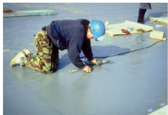
2 ábra: A hegesztési varrat ellenőrzése
