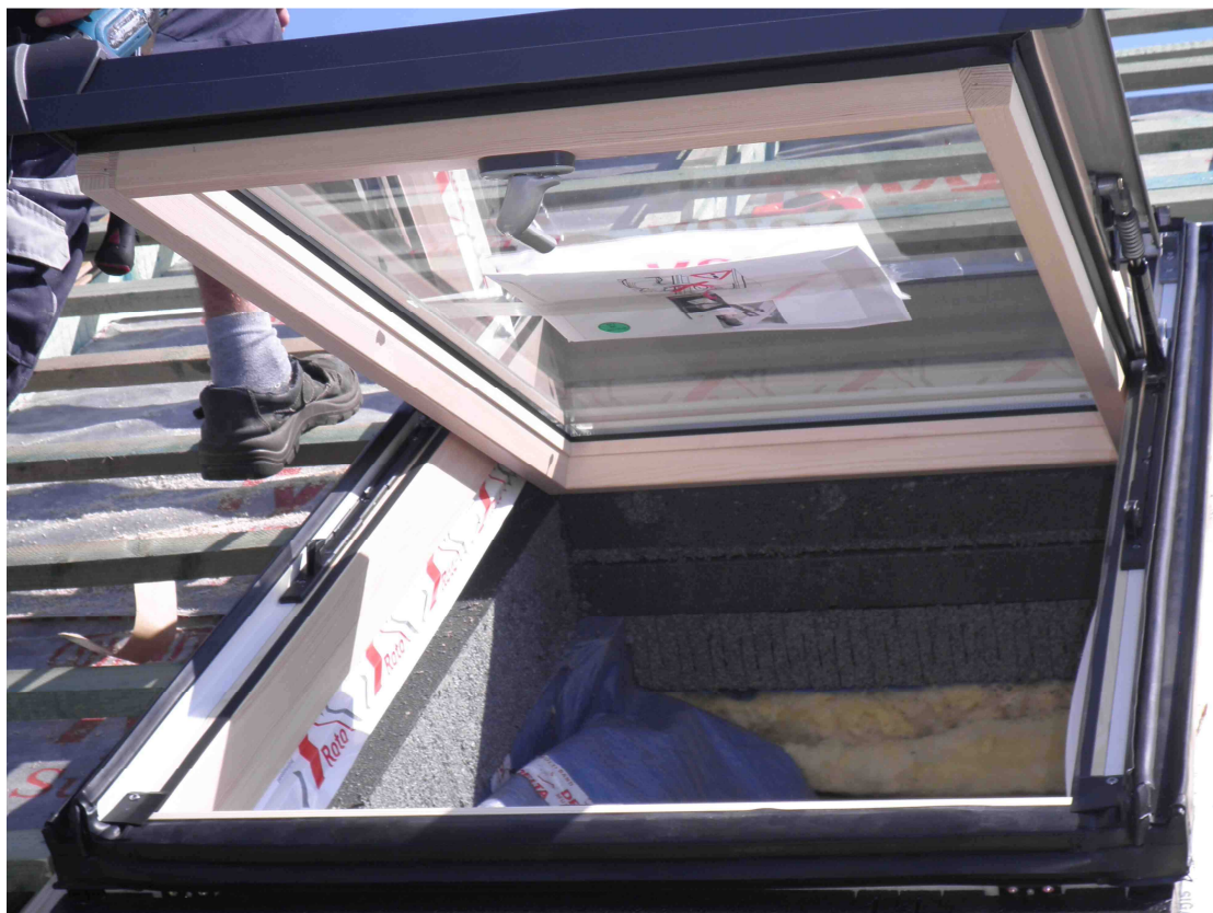
5. Tetősík ablak beépítés. Jól látszik a régi, vékony hőszigetelés, a Klemmfix ® és a Manzárd Grafit ® rétegek
