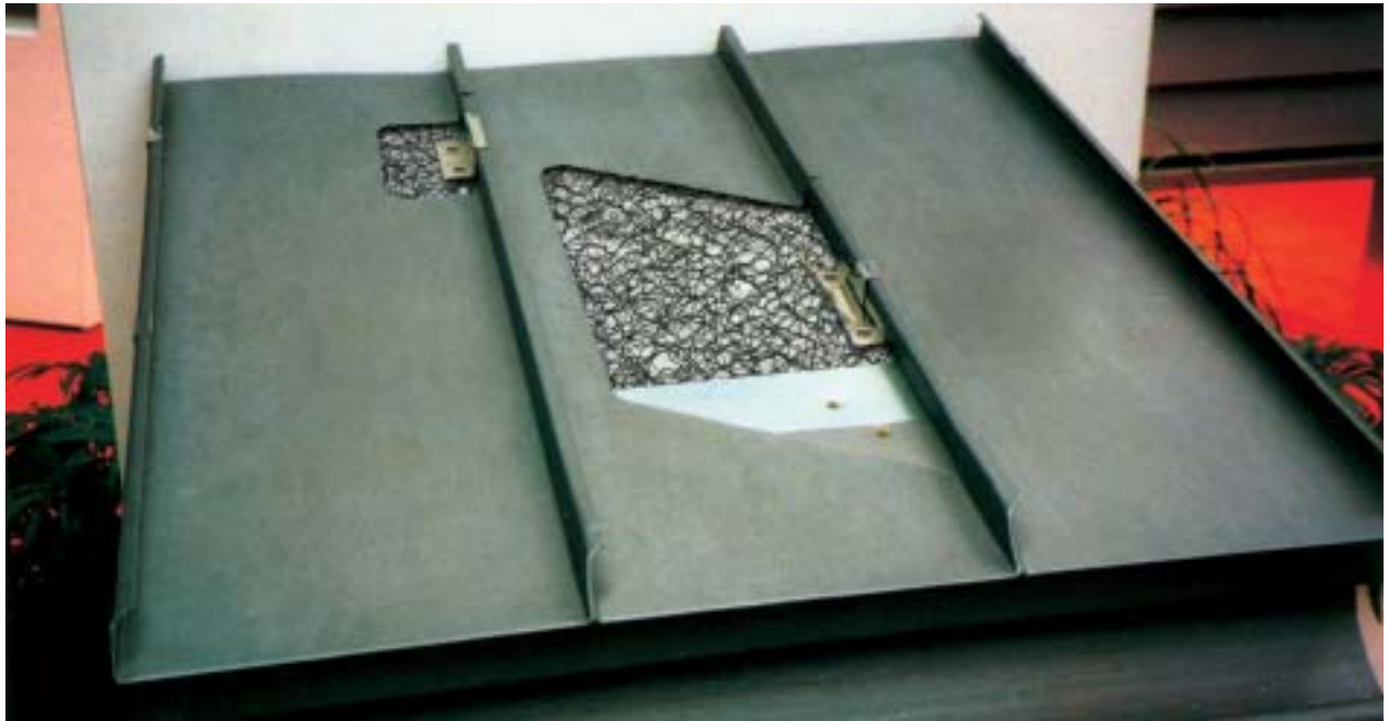
Kis lejtésű PLX lemezfedés szellőzőszőnyeg elválasztó réteggel
