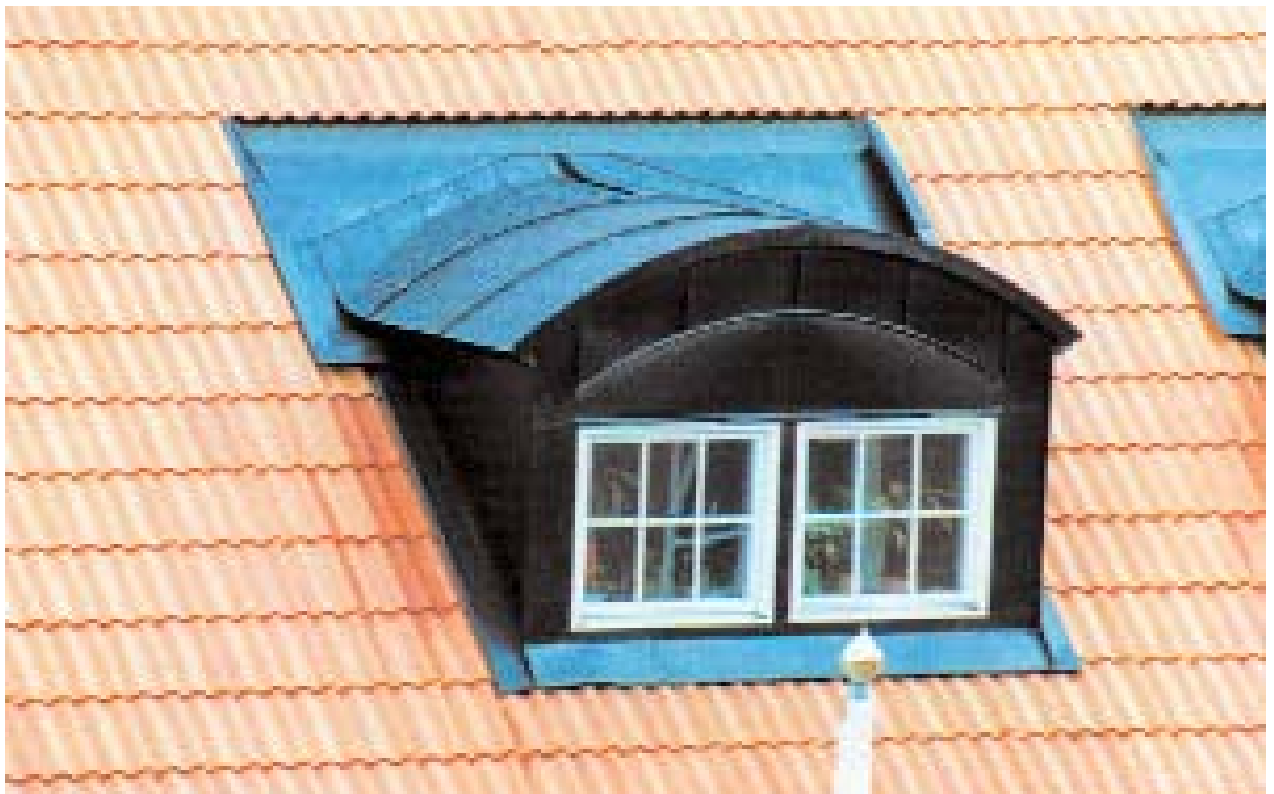
Tetőablak szegélyezése cserépfedésnél
