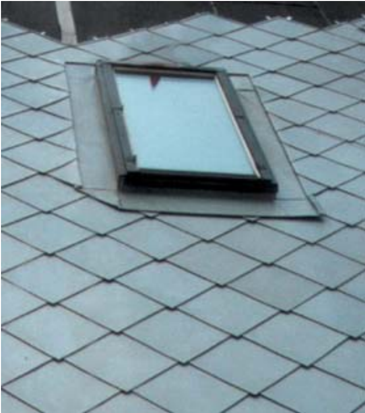
Tetőablak beépítése pikkelyes tetőfedésbe
