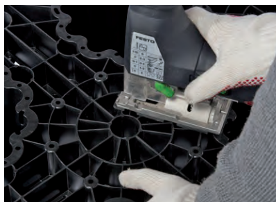
Vor dem Einbau der Grundelemente sind die Öffnungen für die Be- und Entlüftung bzw. die Inspektionsöffnungen am Grundelement auszuschneiden!
