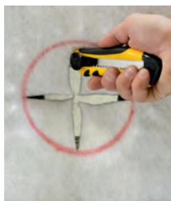
Vor dem Einbau der Grundelemente sind die Öffnungen für die Be- und Entlüftung bzw. die Inspektionsöffnungen am Grundelement auszuschneiden!
