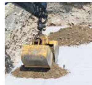
Földfeltöltés a rendszer tetejére
