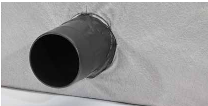
A geotextília rögzítése a csőcsatlakozáshoz
