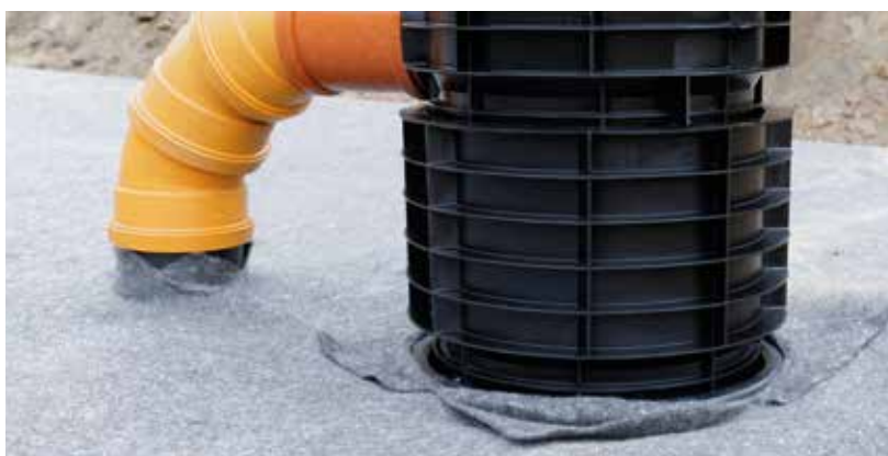
Szellőzőcső csatlakozása a nyaktaghoz.
