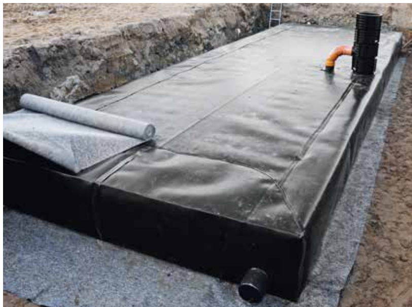
A vízzáró fólia hegesztését követően geotextíliával fedjük a teljes rendszert
