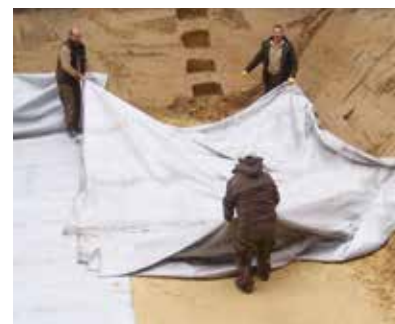
A teljesen sík és kömentes felület kialakítását követően leterítjük a geotextíliát.
