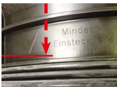
Állítsuk be a minimum mélységet!
