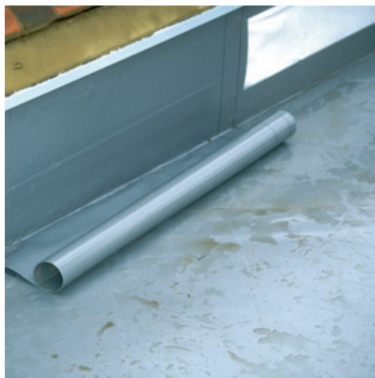
3. kép: Sarokrögzítés RENOLIT ALKORPLAN 81170 fóliabádoggal
