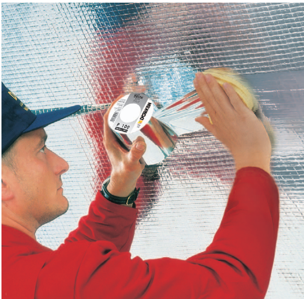
A DELTA®-ragasztószalagokkal a lég- és párazáró rétegek – a képen DELTA®-REFLEX – könnyen beépíthetők.
