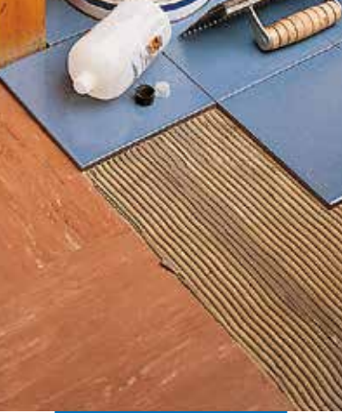
Ragasztás meglévő PVC burkolatra
