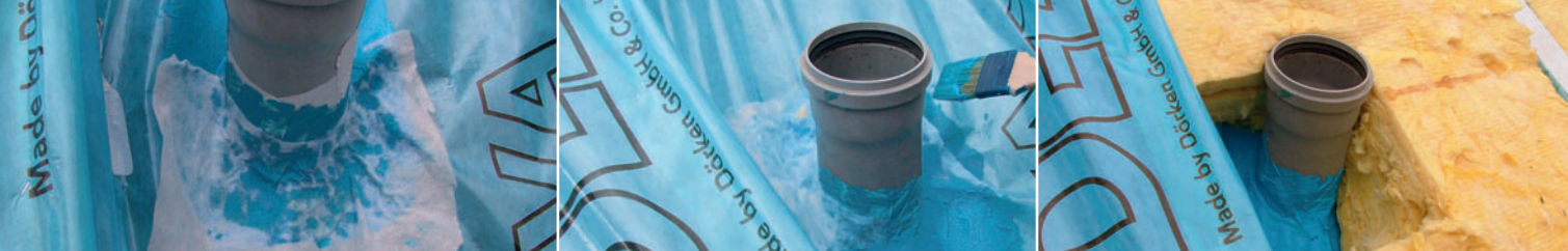
DELTA®-LIQUIXX tetőáttöréshez – kívülről történő felújításnál.
