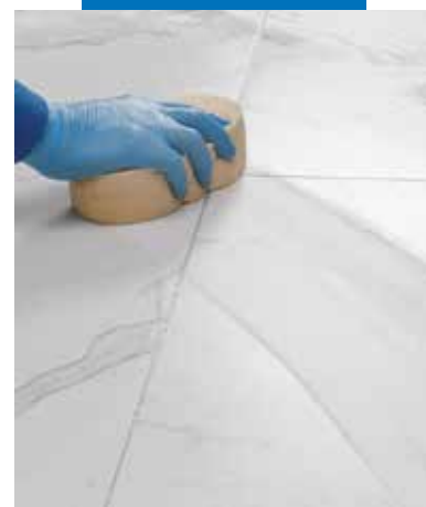
A fugák végső tisztítása kemény cellulóz szivaccsal
