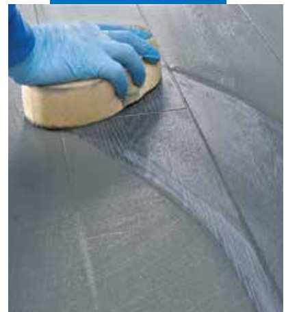
A fugák végső tisztítása kemény cellulóz szivaccsal
