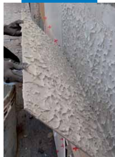
Burkolólap teljes hátoldali fedettségének ellenőrzése homlokzaton
