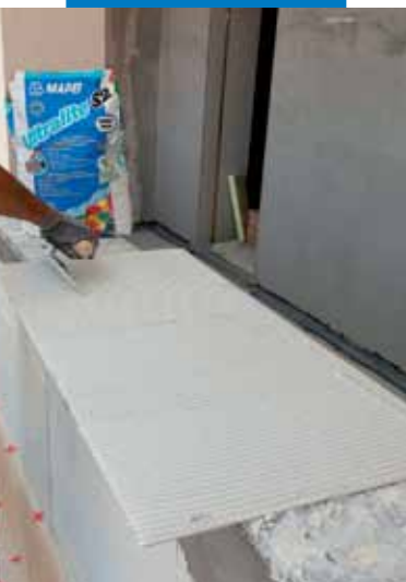
A ragasztó felhordása a burkolólap hátoldalára
