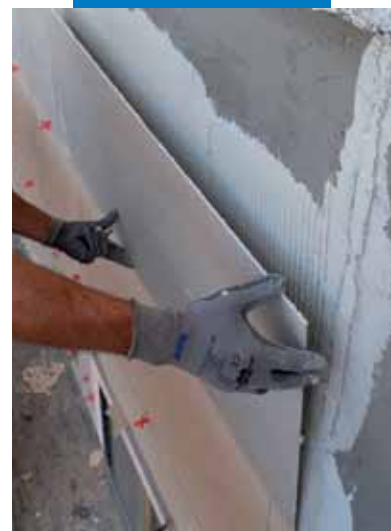
Vékony porcelán burkolólap ragasztása homlokzatra
