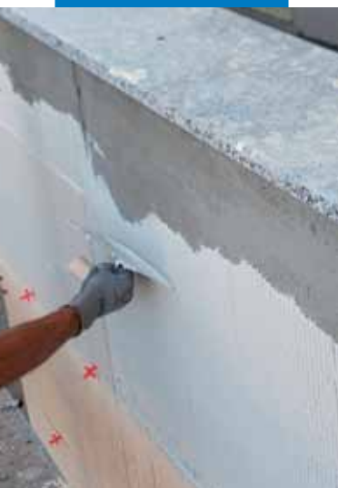
Fektetés homlokzatra: ragasztó felvitele az alapfelületre
